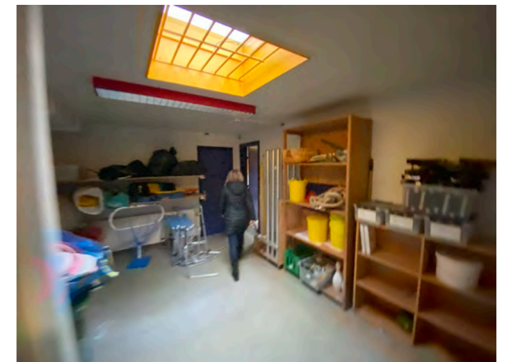
Kælder i vestvendt bygning
